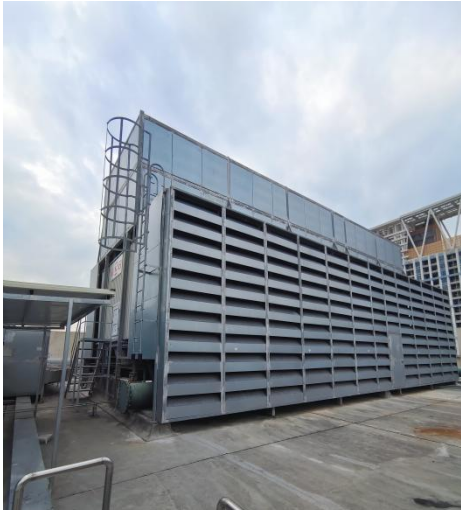
楼顶冷却塔设置加厚隔音房
