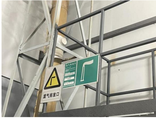
废水处理站废气排放口
