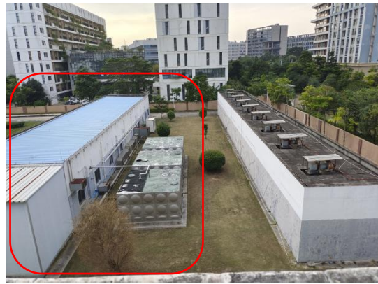
项目北面-园区废水处理站
