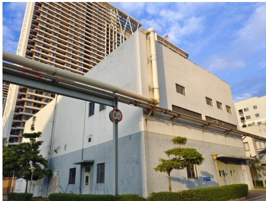
项目北面-工程楼
