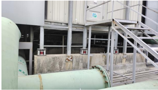
楼顶冷却塔设置加厚隔音房
