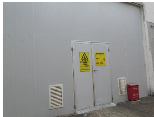
危险废物暂存间
