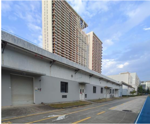
园区废水处理站
