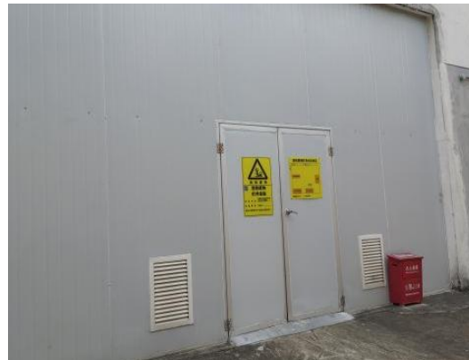
危险废物暂存间
