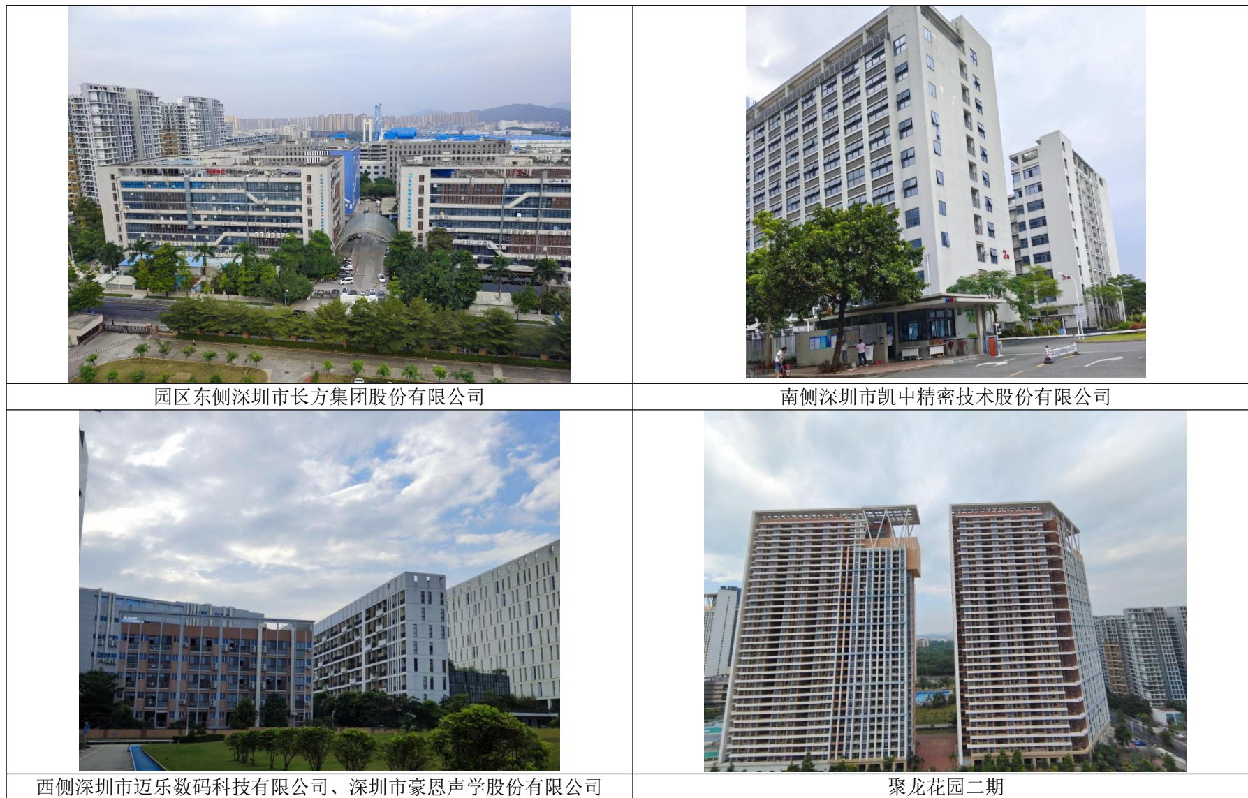
图 3.1-2 信立泰医药科技园四至现场照片
