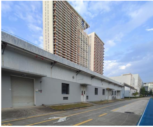
园区废水处理站
